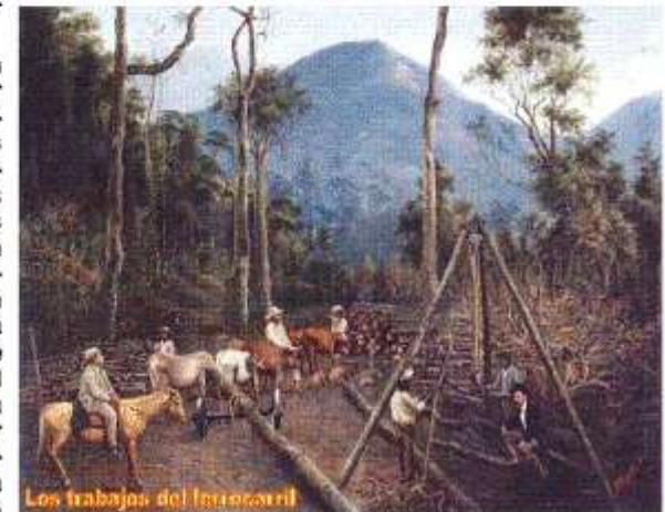
Los trabajos del ferrocarril
