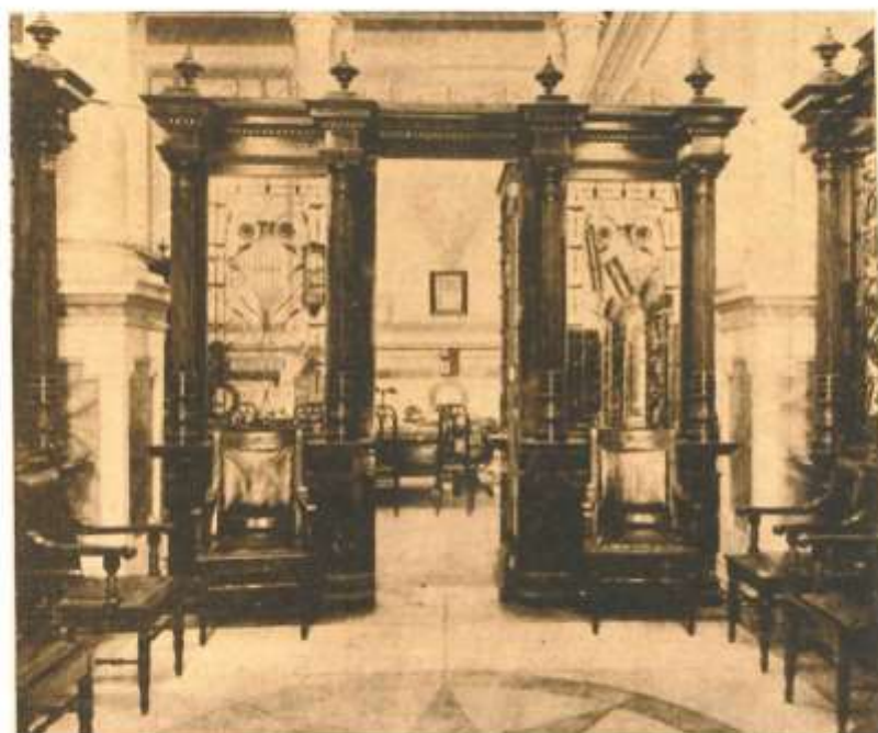
Puerta de acceso a la oficina de gerencia del nuevo edificio del Banco del Ecuador.
